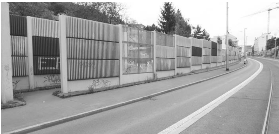
[OBR. 11] Protihlukové stěny v prostoru městské ulice, degradující charakter veřejného prostranství
