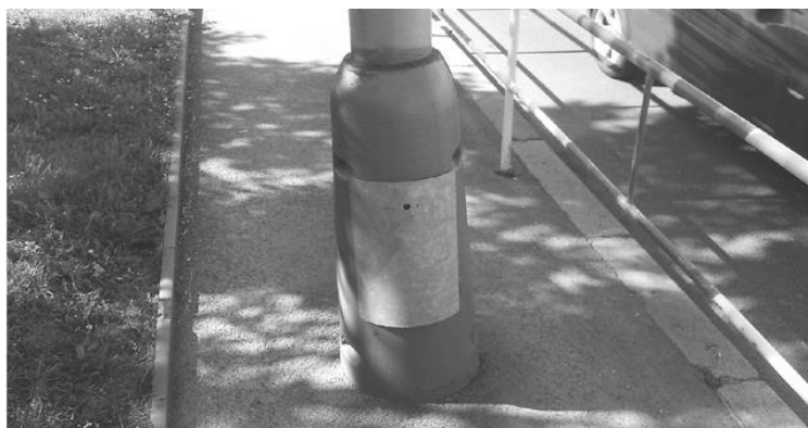
[ OBR. 10 ] Umístění stožáru veřejného osvětlení v chodníku způsobem, který brání pěšímu pohybu
