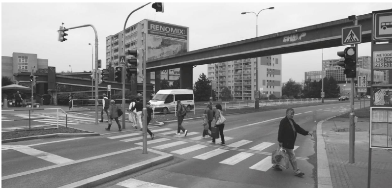
[ OBR. 12 ] Nevhodně řešené mimoúrovňové křížení pěšího pohybu s komunikací. Pro nefunkčnost byl nejprve paralelně zřízen úrovnový přechod a nakonec nadchod zcela odstraněn.
