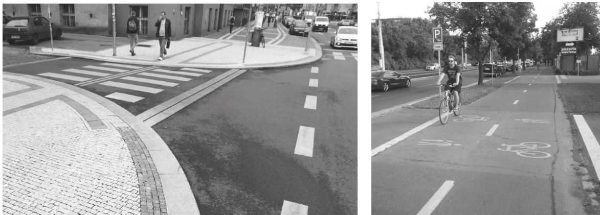
[OBR. 13] Příklad chodníkového přejezdu (vlevo) a stezkového přejezdu (vpravo)
